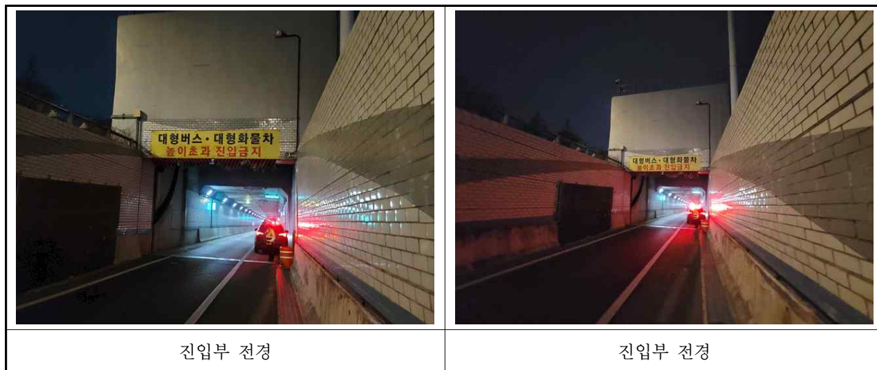
【사진 3.3.35】갯문 전경
