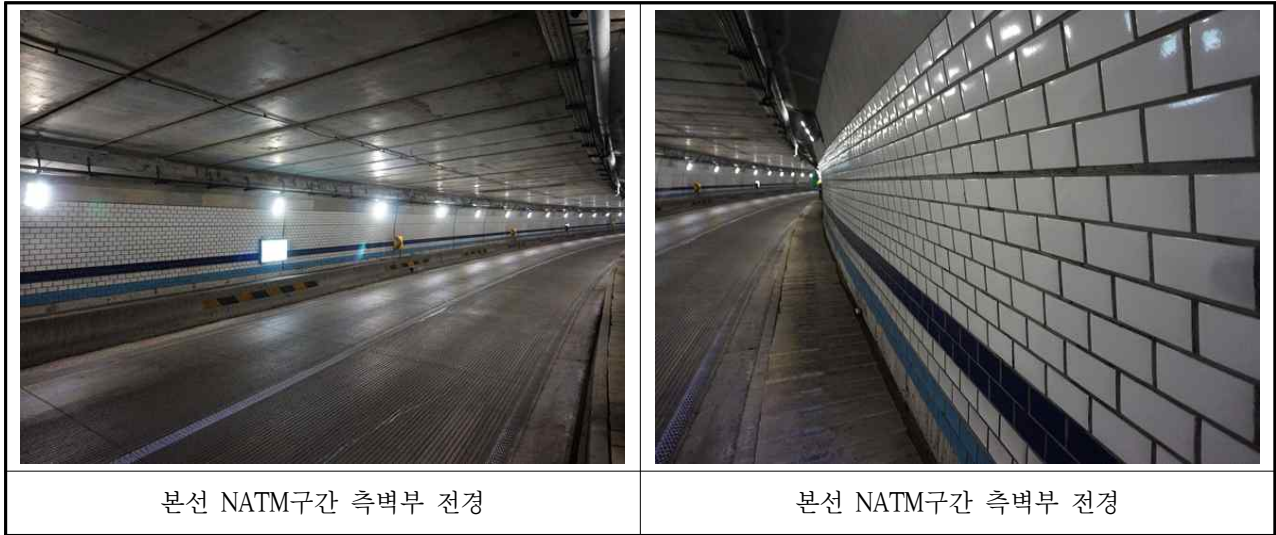
【사진 3.3.7】 NATM구간 측벽부 전경
