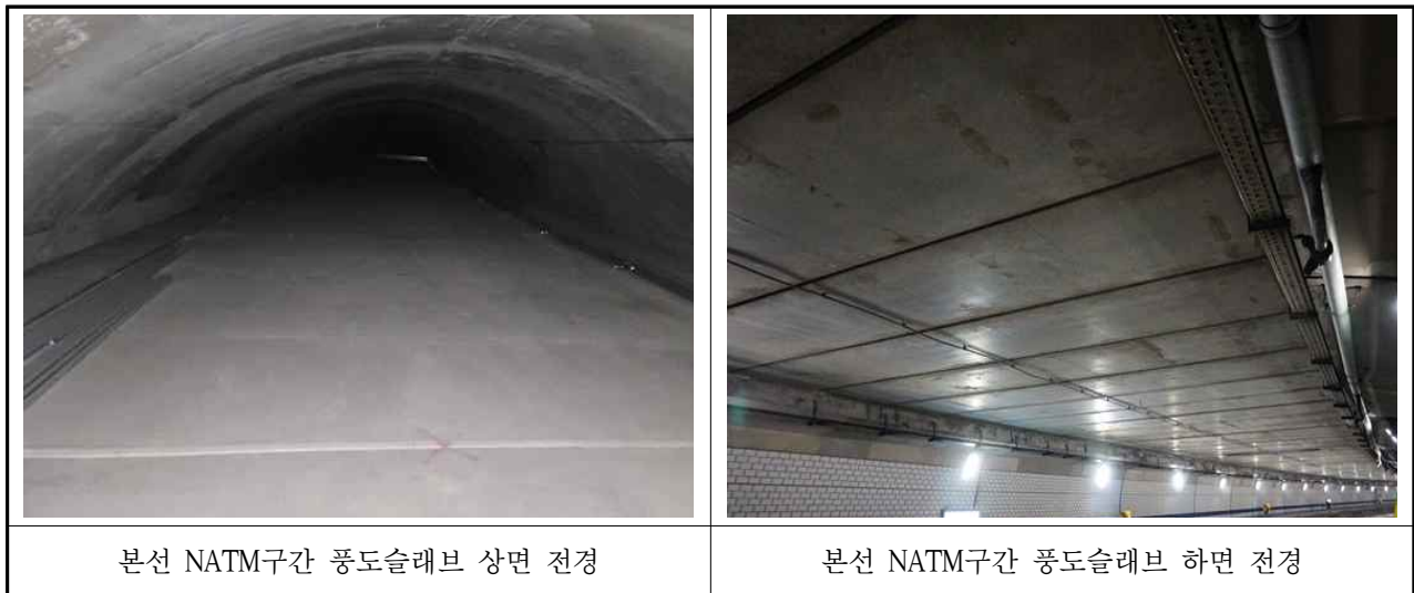
【사진 3.3.9】 NATM구간 풍도슬래브 전경
