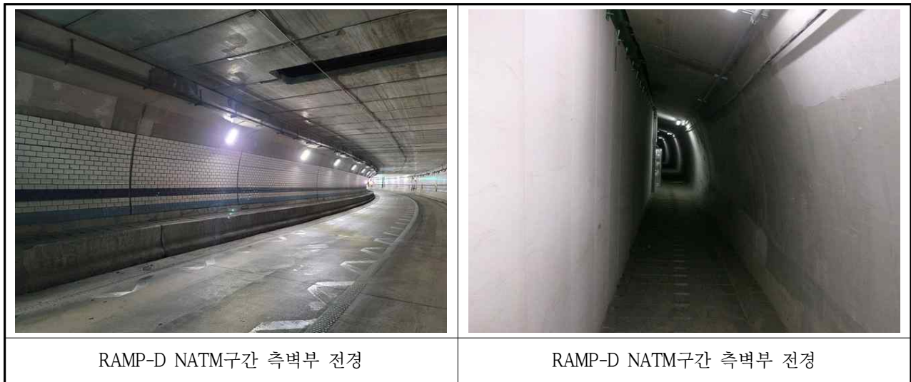
【사진 3.3.25】 NATM구간 측벽부 전경
