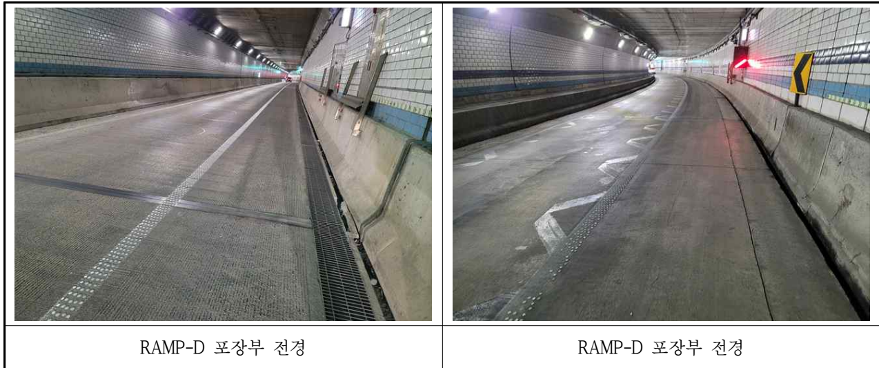
【사진 3.3.29】 포장부 전경
