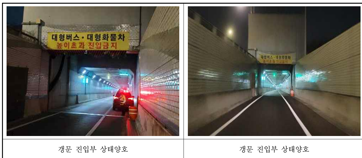
【사진 3.3.36】갯문 손상현황
